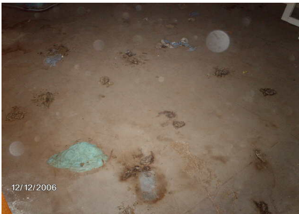
Divisões interiores a funcionar como Instalações Sanitárias
